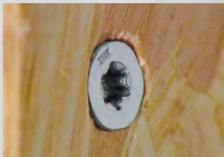
Das HECO-UNIX®-Vollgewinde mit veränderlicher Steigung zieht die Bauteile schon beim Verschrauben zusammen. Das tiefe Versenken des Kopfes ist daher nicht notwendig.
